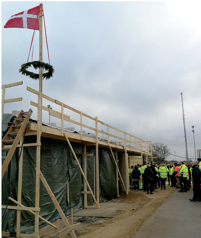
Rejsegilde på det kommende renseanlæg i Gilleleje.
