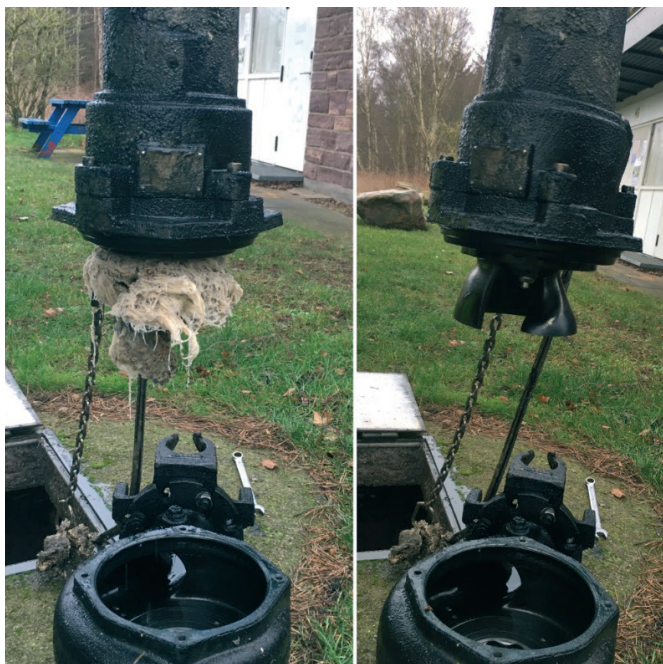
Pumpe før og efter rensning
