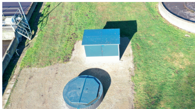
Pumpestation og pumpehus på Græsted Renseanlæg
