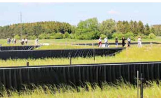
Bioslamanlægget i Pårup blev indviet 6. juni 2019.
